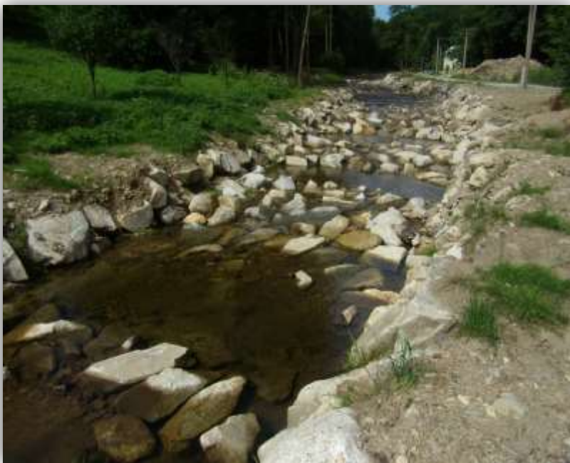
Nově podélně i příčně stabilizované koryto vodního toku v intravilánu Vojtovic
