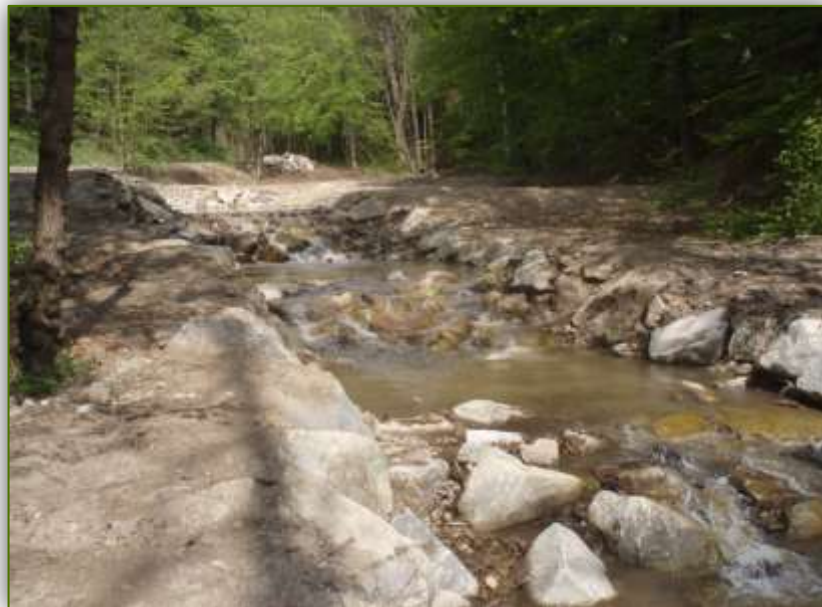
Kaskáda balvanitých skluzů se stabilizační tůň, výška skluzu 0,6 m, délka 7 m a hloubka tůně min. 0,4 m
