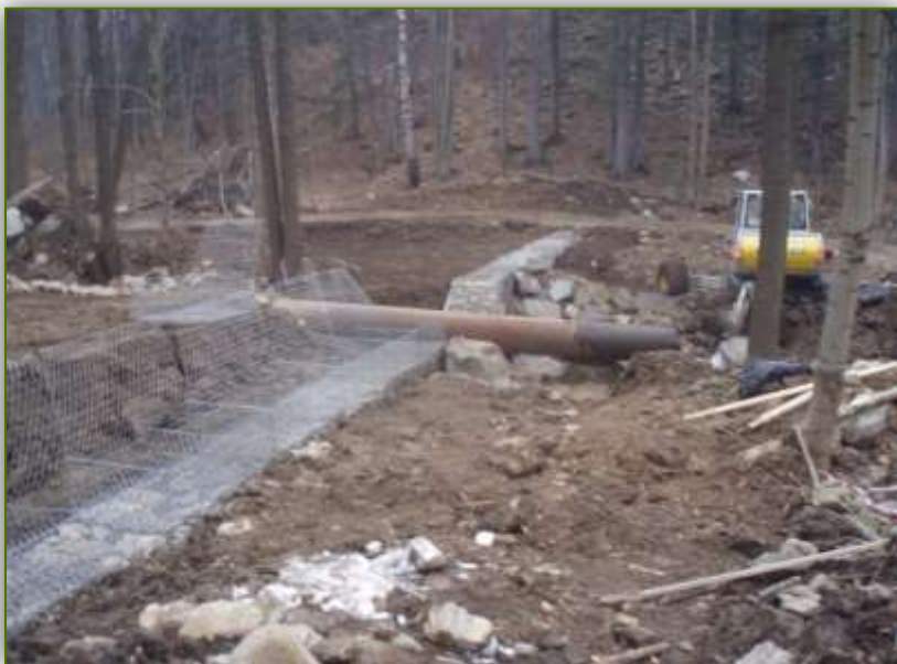
Veškeré kamenivo do drátokamenných košů bylo vysbíráno ze splavenin po povodni 6/2006
