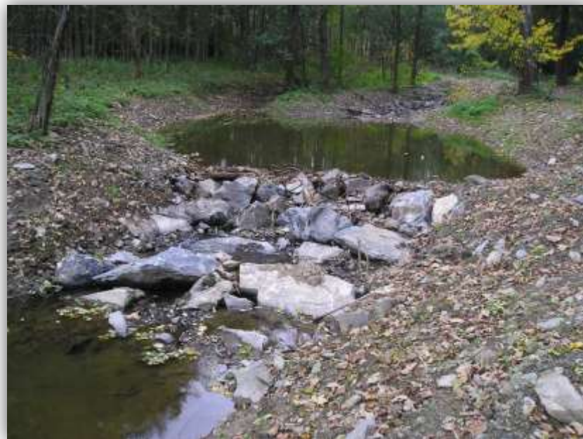
Nová průtočná tůň, která je příčně stabilizována balvanitým skluzem
