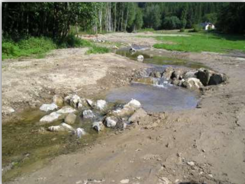
Příčné balvanité skluzy se stabilizační tůň
