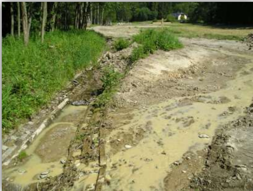
Výstavba nového koryta Jeleního potoka v horní části toku
