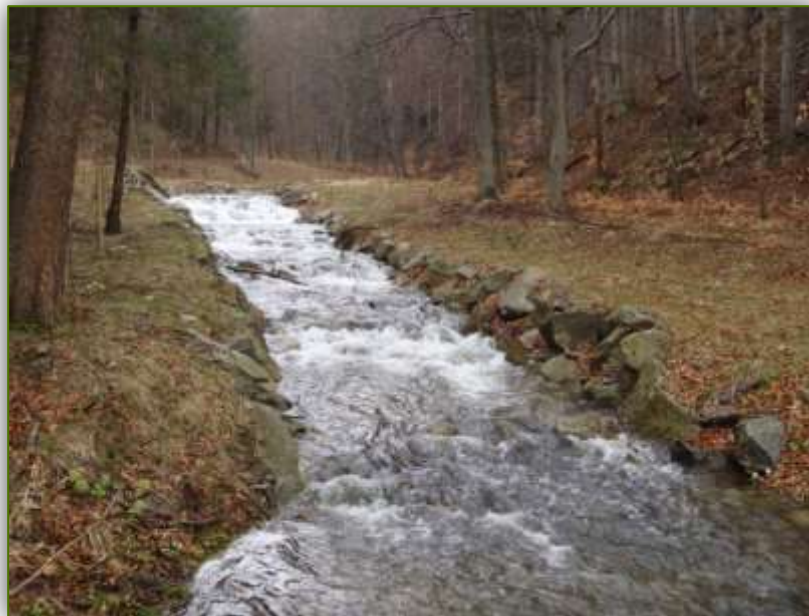
Stejná kaskáda balvanitých skluzů se stabilizační tůň v období jarního tání
