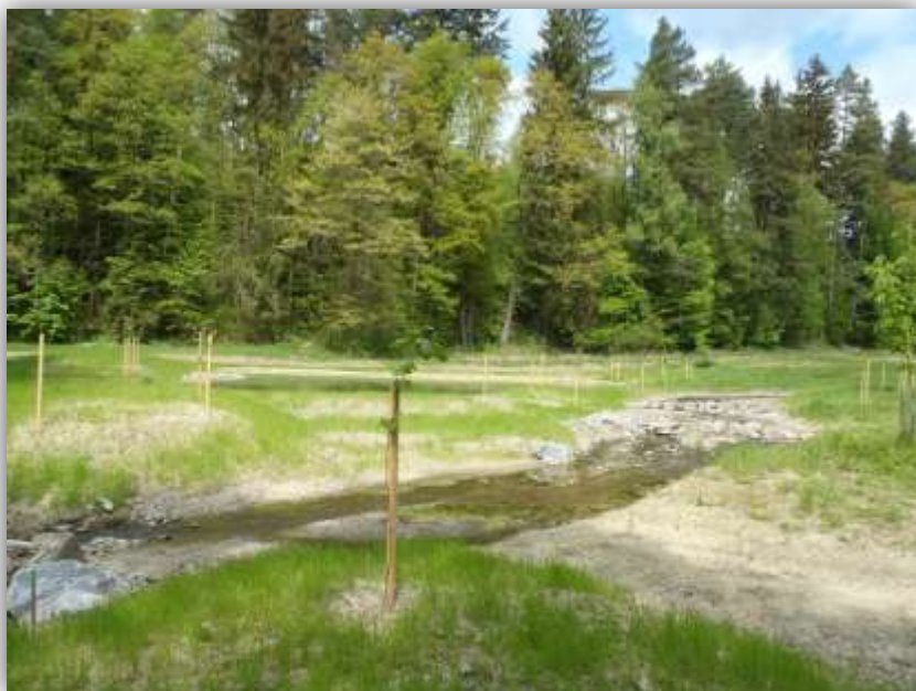
Nově zrevitalizované koryto s boční tůňí a zemním valem
