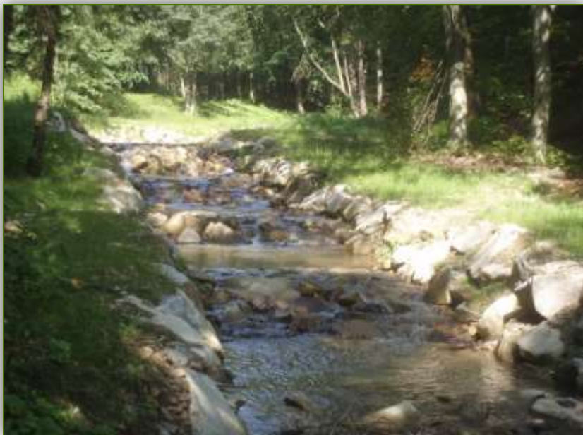
Kaskáda balvanitých skluzů se stabilizační tůň
