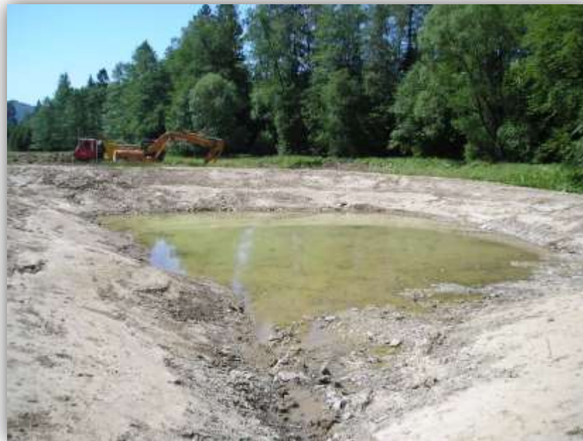
Vytváření boční tůně o nezámrzné hloubce 0,8 m
