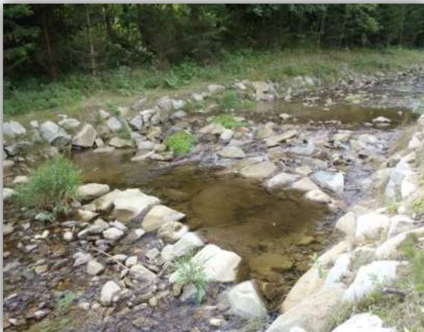
Balvanitý skluz se stabilizační tůní
