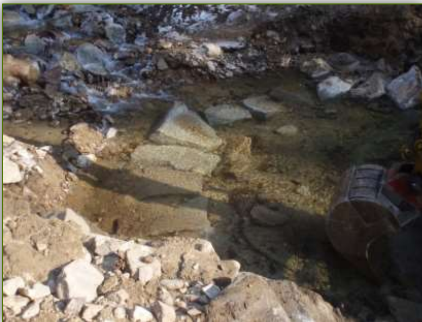
Balvanitý dnový pas z lomového kamene, hmotnost kamenů nad 1000 kg
