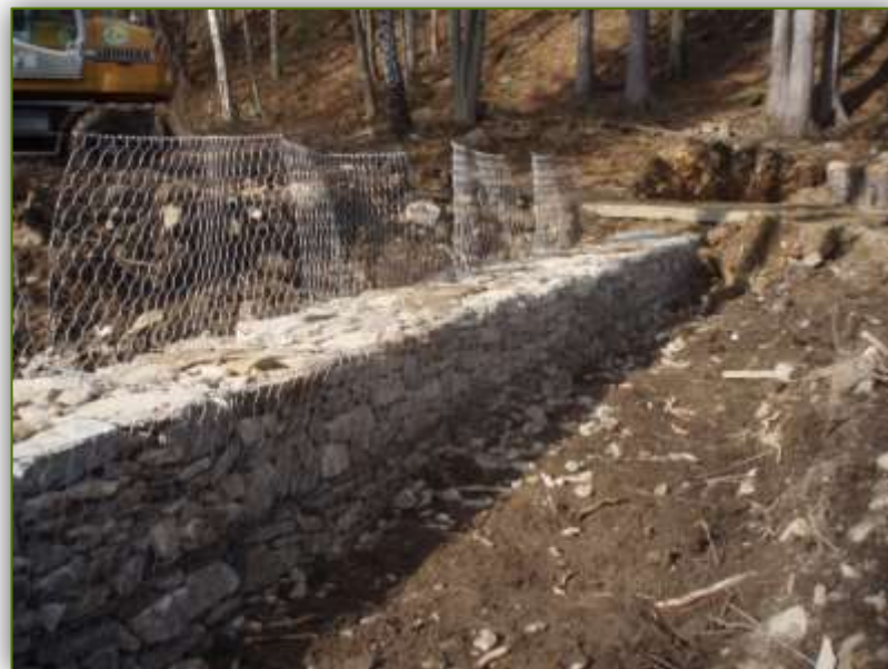
Výstavba příčného zemního valu se stabilizačním jádrem z drátokamenných košů
