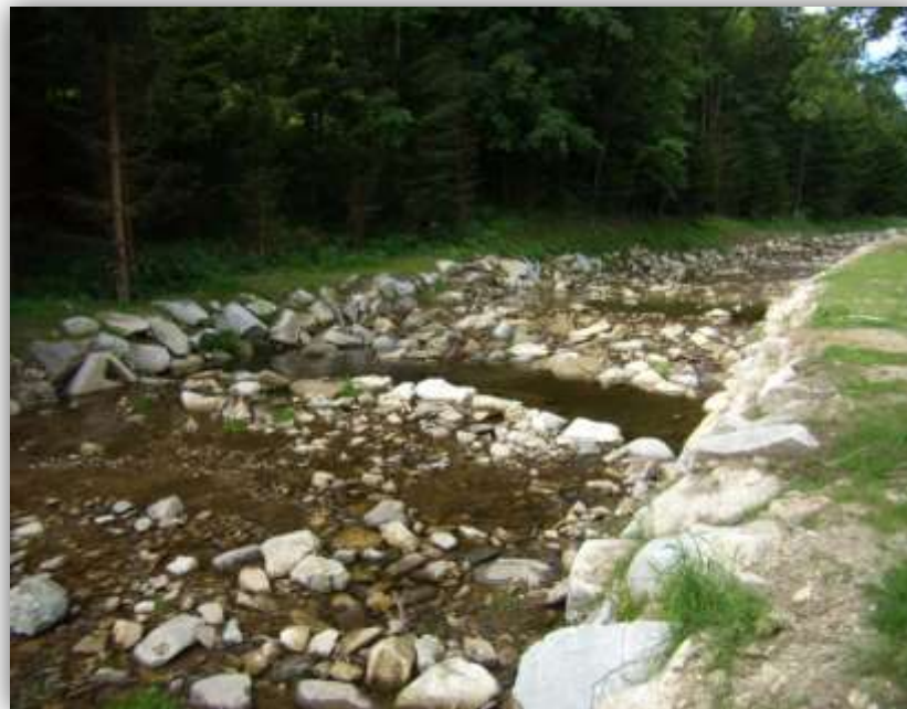
Stabilizované a rozšířené koryto v intravilánu Vojtovic
