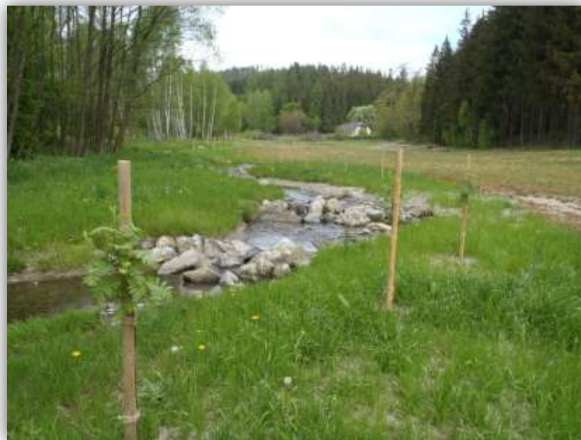
Rozvolněné koryto toku s balvanitými objekty a náhradní výsadbou
