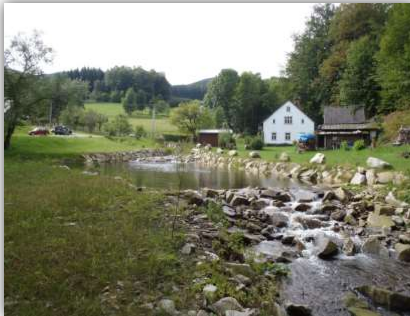
Nově upravené koryto, balvanitý skluz s vytvořeným retenčním prostorem v intravilánu Vojtovic
