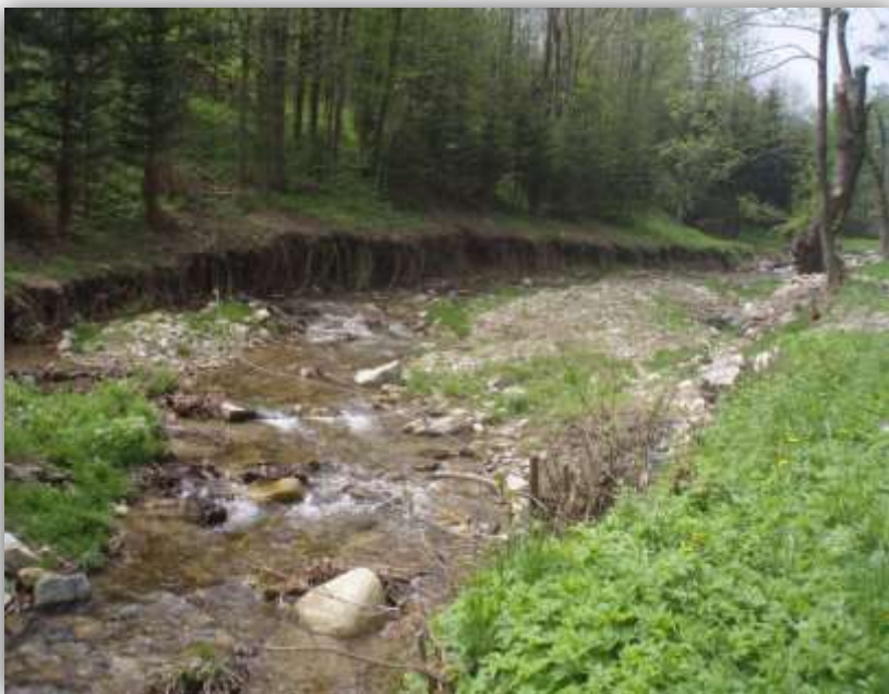
Břehová nátrž po povodni v intravilánu obce
